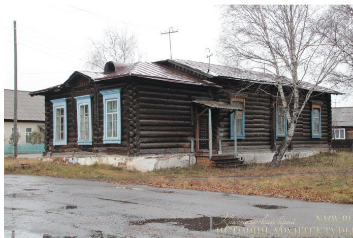
Барак №3 комплекса городской больницы по ул. Декабристов, 1
